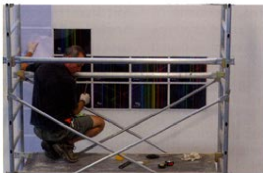
Figura 3. Instal·lació del mural Homenatge als elements al CRAI Biblioteca de Física i Química, Universitat de Barcelona, 2011. Fotografia: S. Álvarez.
